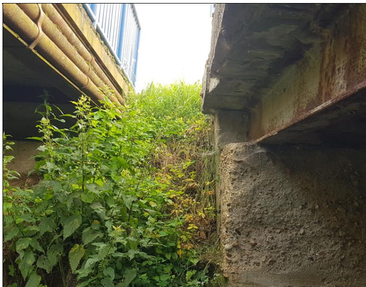
dždění na OP2 vevo, špatný stav podhledu mostovky
