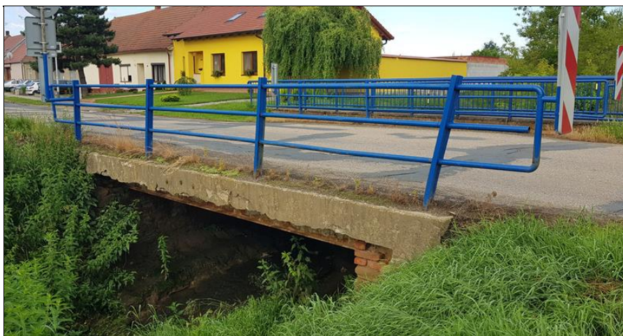
deformace sloupku zábradlí, rozpad říms
