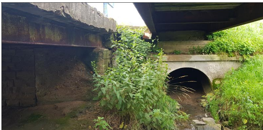
vyústění kanalizace na vtoku
