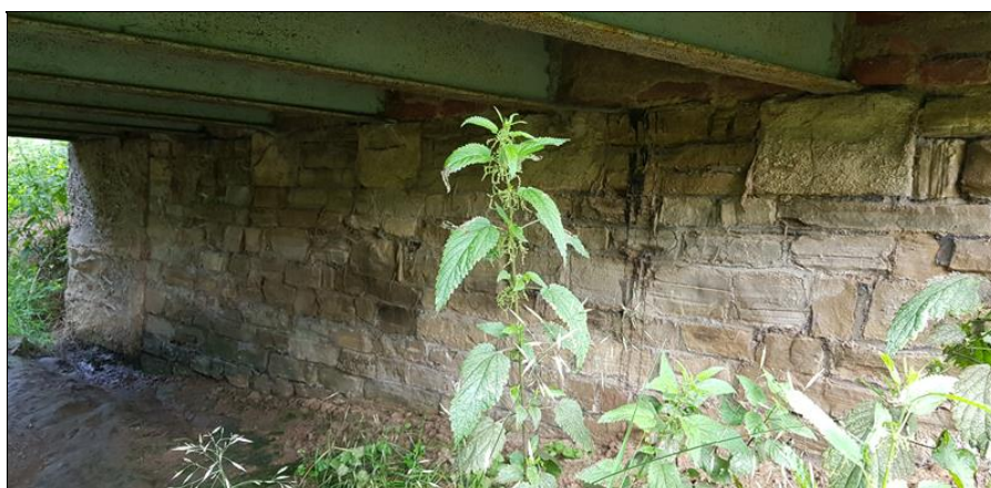
pohled na OP1, rozpad povrchů
