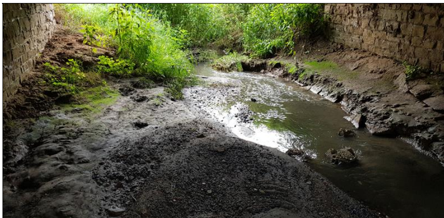
zanesené koryto pod mostem , rozvolněné zpevnění u opěr
