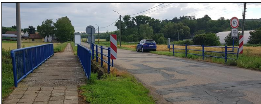
pohled proti staničení , zaplátovaná vozovka, značně převýšená
