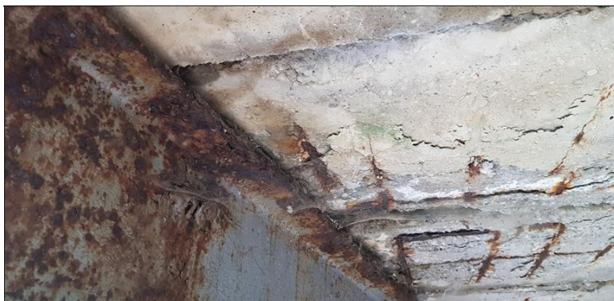
koroze ocel. nosníků uý místy listová, rozpad prefa mostoky
