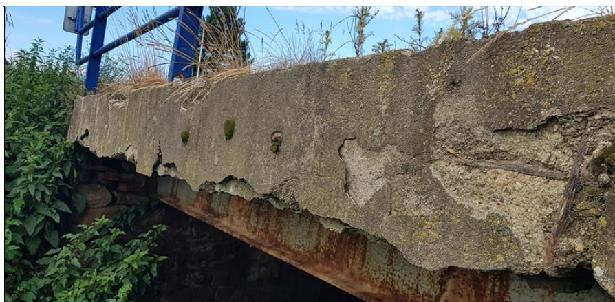
odpadlá omítka a krytí výztuže na římsách , koroze
