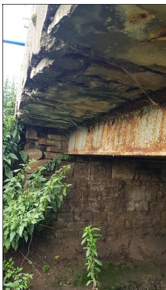
dždění na OP2 vevo, špatný stav podhledu mostovky
