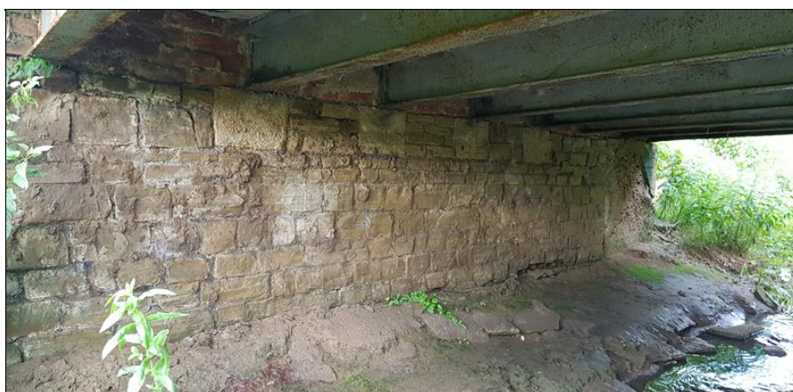
pohled na OP2, rozpad povrchů
