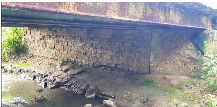
OP2 původní a dobet. část rozpad povrchů, koroze nosníků
